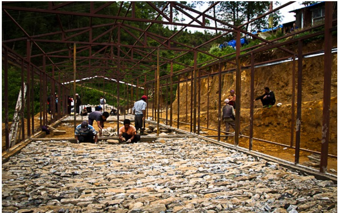
Der Bau nimmt Gestalt an (Stand Anfang Mai)
